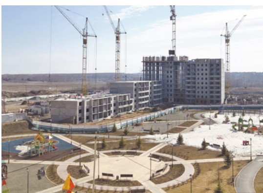
Строительная площадка дома 704 (стр) в микрорайоне «ПРИОЗЕРНЫЙ»
